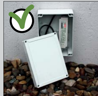
Korrekte Installation im Elektrohäuse Correct installation inside the electrical cabinet Installation correcte dans le carter électronique
